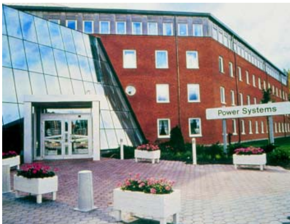
ABB Power Systems kontorsbyggnad i Ludvika
